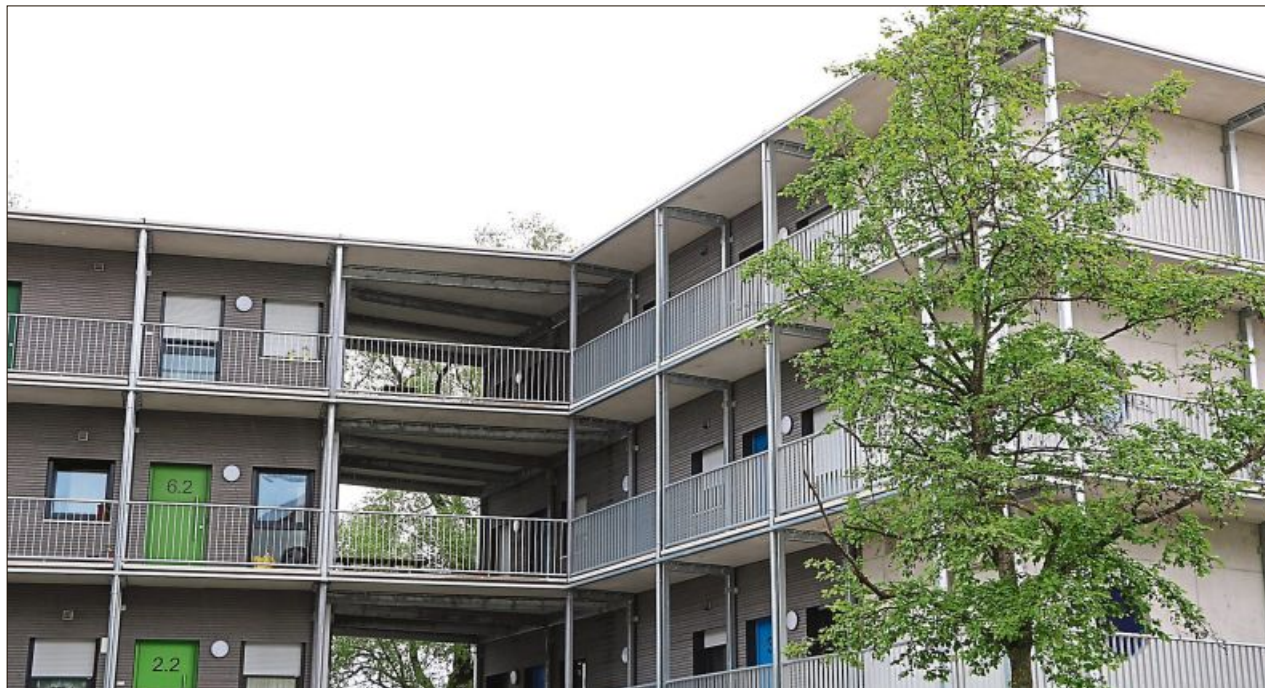
20 Wohnungen gibt es in der Anlage, die in Holzmodulbauweise errichtet wurde. Hier wohnen auch die Tagesmütter, die die Kinder der Alleinerziehenden betreuen.
