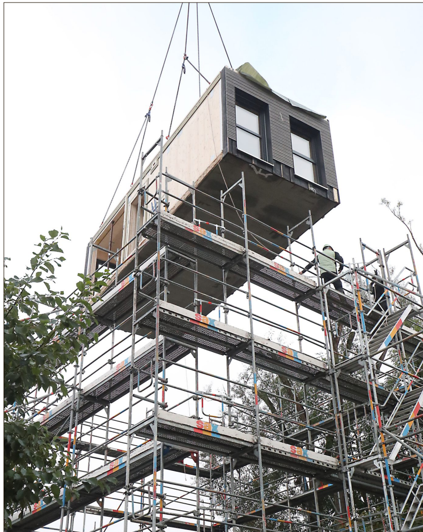
Der Kranführer balanciert das Holzmodul in der Luft und senkt es langsam zwischen den Gerüsten auf der freien Fläche im hinteren Teil der Baustelle ab.
