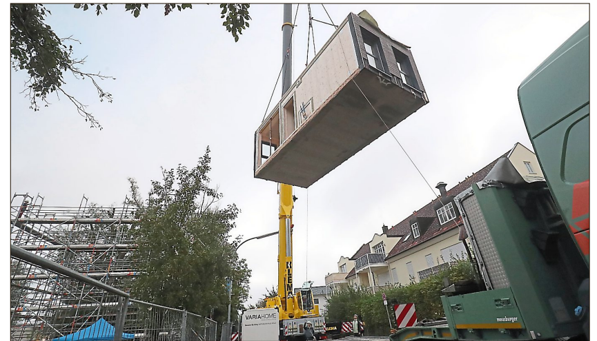
Direkt von der Ladefläche des Lkw werden die ersten Holzmodule am Dienstagmorgen auf das vorbereitete Areal auf der Baustelle gehoben.
